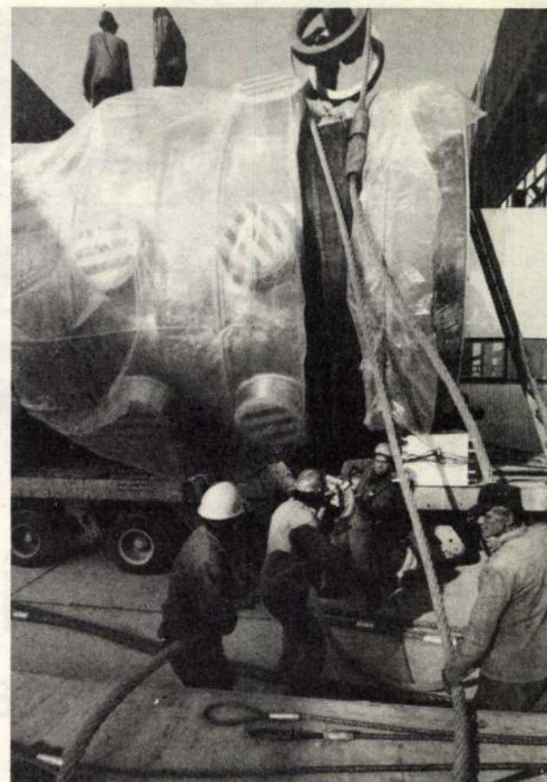
A paksi atomerőmű reaktortartályát kilencvenhat kerekés trélerre emelik.
