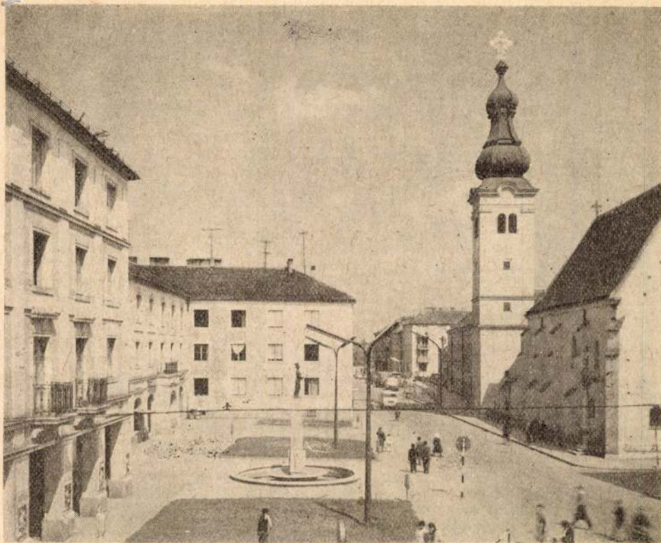
A Savaria tér. Balra új épületek — jobbra a helyreállított középkori templom
