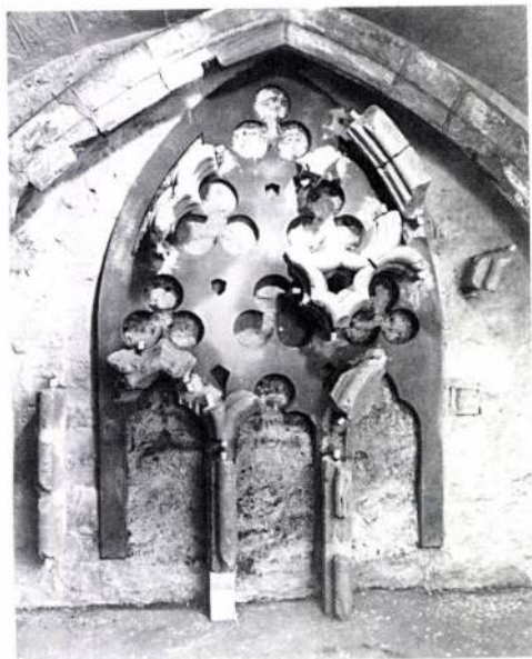
Többemeletes, háromkaréjos alakzatokból összeállított mérmű: Eger, vár, püspöki palota lakótornyáról, felállítva az egri vár középkori kőtárában
