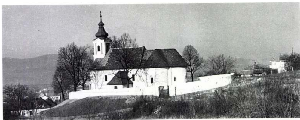
Tar, római katolikus templom és körítőfalának képe helyreállítás után (1980-82)
