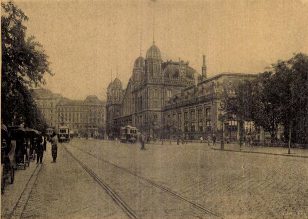
A PÁLVAUDVAR TERÉZKÖRUTI HOMLOKZATA.
