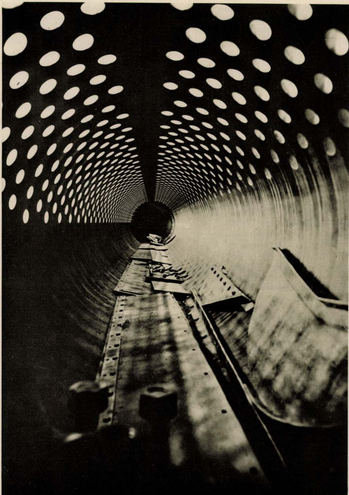
BUDAPEST SZÉKESFŐVÁROS ELEKTROMOS MŰVEINEK KELENFÖLDI TELEPE. A 35 ATMOSZFÉRA NYOMÁSÚ GŐZTARTÁLY BELSEJE
