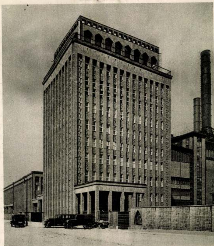
GROSSKRAFTWERK KLINGENBERG. FŐBEJÁRÓ A JÓLÉTI INTÉZMÉNYEK ÉS AZ IRODÁK ÉPÜLETÉVEL Tervezték: Klingenberg és Issel építészek
