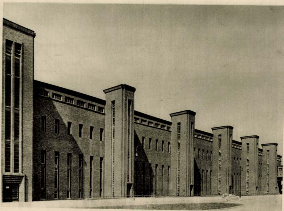
GROSSKRAFTWERK KLINGENBERG. A 50.000 VOLTOS KAPCSOLÓHÁZ A CÖPENICKER CHAUSSÉE FELŐL Tervezték: Klingenberg és Issel építészek
