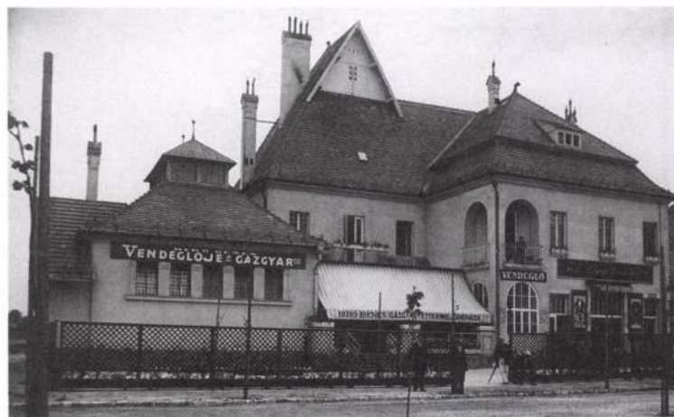
AZ EGYKORI MUNKÁSKASZINÓ ÉPÜLETE EREDETI ÁLLAPOTÁBAN
