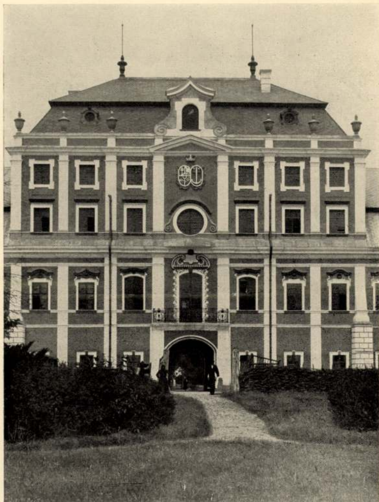
56. — EDELÉNY: A kerti homlokzat részlete Mitte der Gartenfasade — Partie centrale de la façade postérieure Central part of the posterior façade
