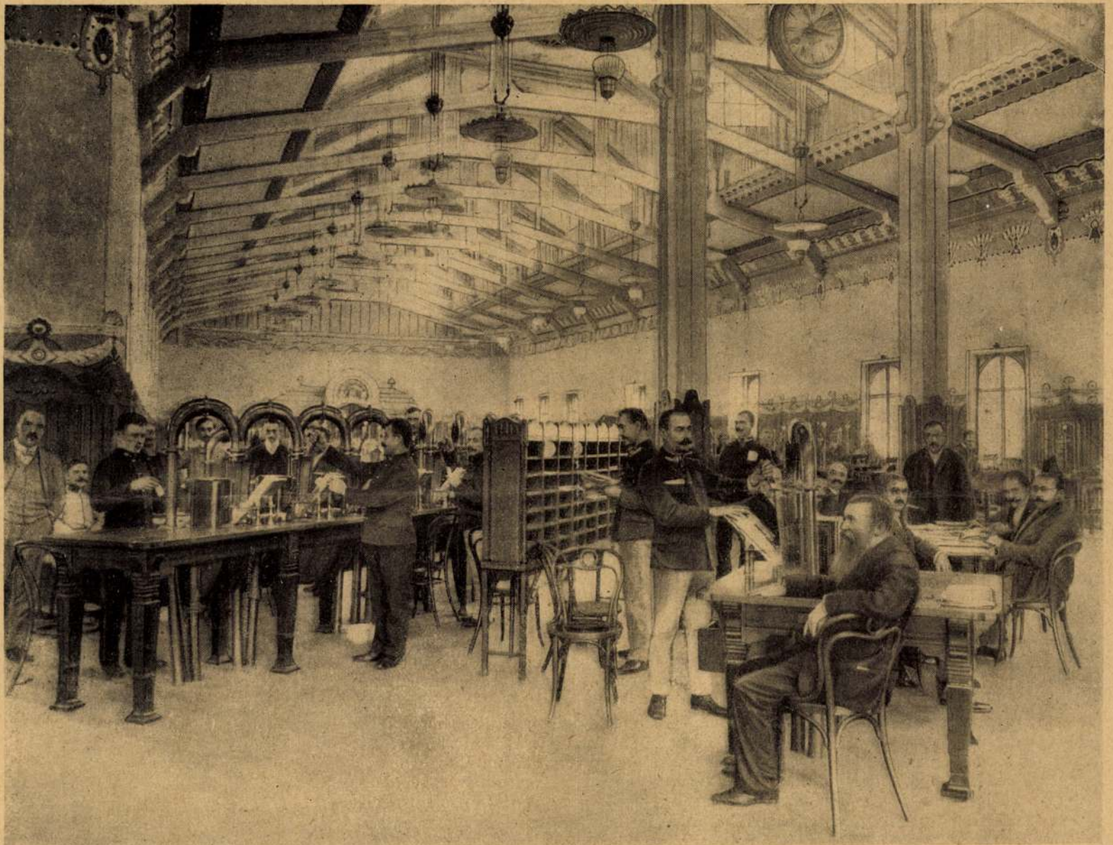
A BUDAPESTI ÚJ TÁVIRDA-KÖZPONT. — IRÁNYÍTÁS, CSÓPOSTA FŐÁLLOMÁS.
