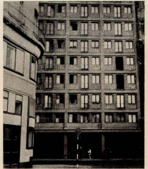
V. Deák Ferenc utca 5. „Darázs”-ház, ahogy a közönség elnevezte. Különbön nyugodt vonalú vázszerkezet, de a kítóltó mezőkben rosszul úsztatott nyílások és az élénksárga színnel hézagolt fekete kerámia nyugtalanra teszik. Az első emeleti mellvéd burkolása érthetetlenül elmaradt, pedig éppen ott lenne a legindokoltabb, az alatta levő párkány miatt; amit jól bizonyít a csapadék felszívódása és a vakolat lefagyása.
