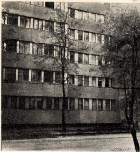
V. Pannónia utca 51. (Finta József — Lakóterv.) A lakóház lényegében „columbárium”: azonos rendeltetésű egységek egymás mellé sorolása. Ennek elegáns megoldását mutatja ez az épület. A mellvédek műkö burkolata időálló, és jól megfelel a pesti légköri viszonyoknak. Az ablakok összeépítését alulemezzel burkolták, melynek csillogása kellemesen élénkíti az egyéb felületek diszkrét színeit.
