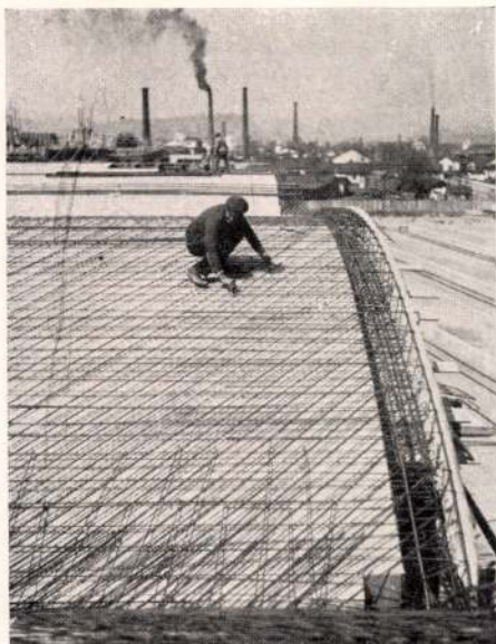
A dongahéj szerelése
