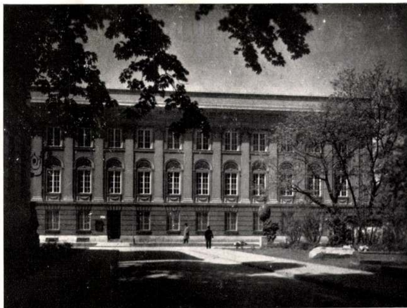
A múzeumi épület oldalhomlokzata
