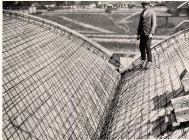
Az állványozás és zsaluzás egyenletes leengedését biztosító elrendezés — A dongazugok szerelése Details der Eisenbetonkonstruktion der Grossmarkthalle in Budapest
