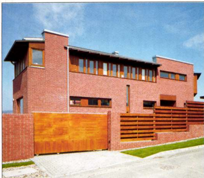
Építész: Schüller Ferenc A Marker Építő Rt. különdíja
