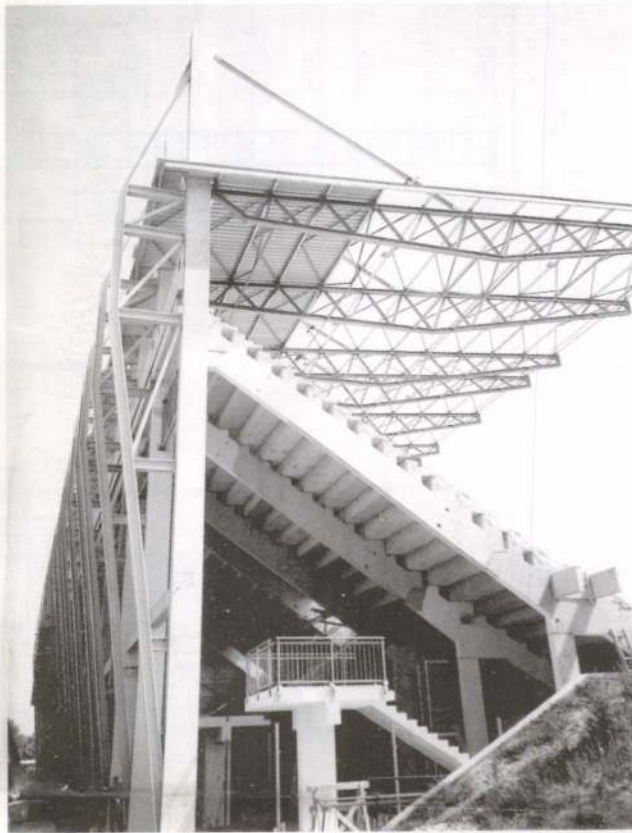
2. ábra: Lelátó, építés közben
