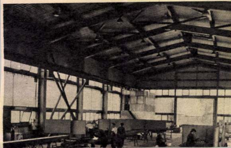
Ezt a presszót is könnyűszerkezetes építési móddal építette a Fémmunkás Vállalat LENT: A Fémmunkás Vállalat egyik könnyűszerkezetes gyártó csarnoka, ahol a hasonló üzemcsarnokok részére az acél idomokat készítik
