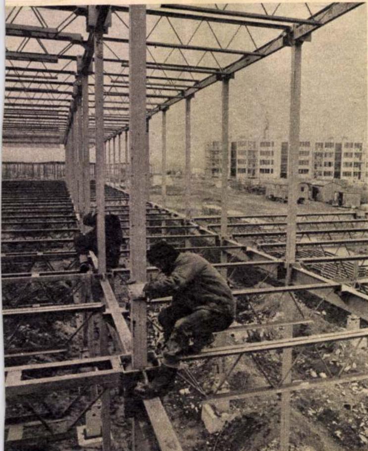
Ma már tantermeket fog közre ez az acélszerkezet egy veszprémi új lakótelepen. Ezt az építéstípusát az Építéstudományi Intézet dolgozta ki
