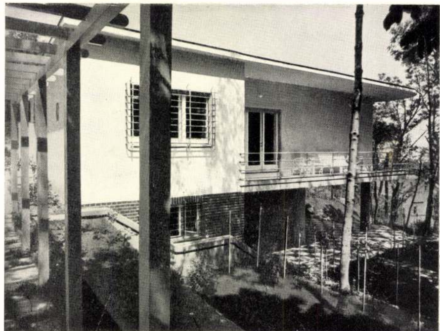
Jobbról fent: a Zólyomi- út felőli kép; lent: a dél- keleti oldal képe.
