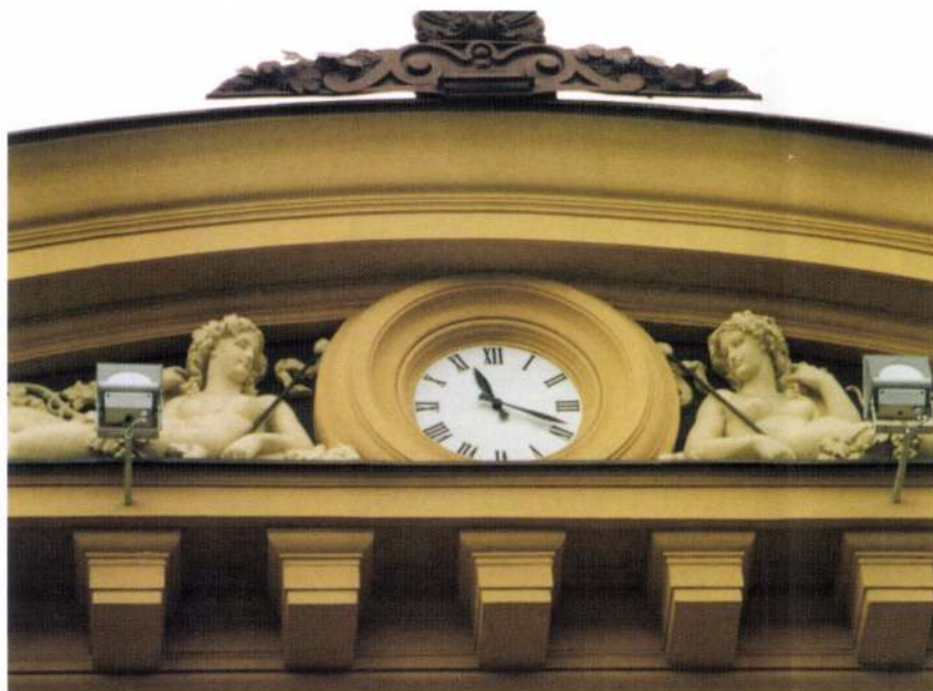
Figurálna výplň štítu a rekonštruované hodiny, 2002 Foto Z. Ševčíková
