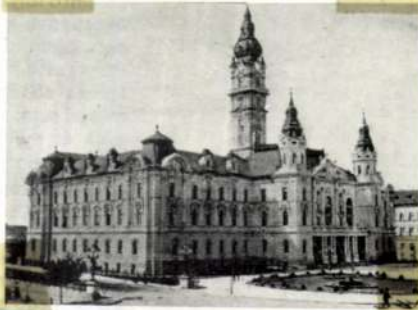
2. Győr, Szabadság tér, Városháza. (Hübner Jenő 1896-1898)
