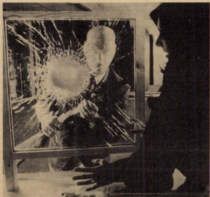
Az angol kutatók által kifejlesztett, egy különleges ragasztóval egymáshoz illesztett üvegrétegekből álló, összesen 63 milliméter vastagságú golyóálló üveg, amely még a géppisztolylőveket is felfogja.
