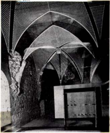
4. Sárospatak, római katolikus templom. A gótikus ablakok hiányzó osztását fémbordák pótolják.
