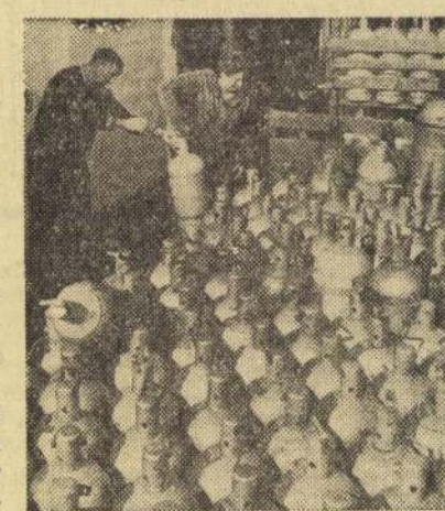
A ceglédiek régi gondját oldotta meg a Török Ignác utcában az év február ele- jén átadott gázcsatorna, amely 1250 propán-bután palack tárolására alkalmas.
