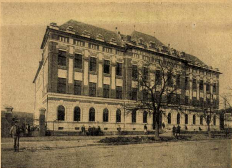
A KOLLEGIUMI FŐGIMNÁZIUM MOST FELAVATOTT ÚJ ÉPÜLETE.
