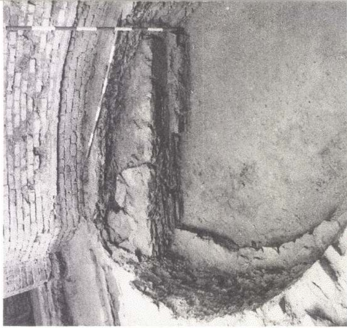
10. kép. A Róka fark -bástya feltárt alapozása (bal oldalt) ráfút az akkor ma
