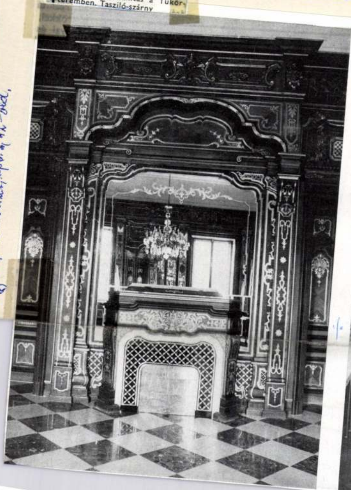
3. Kandalló helyreállítás a Tükör- teremben. Tasziló-szárny
