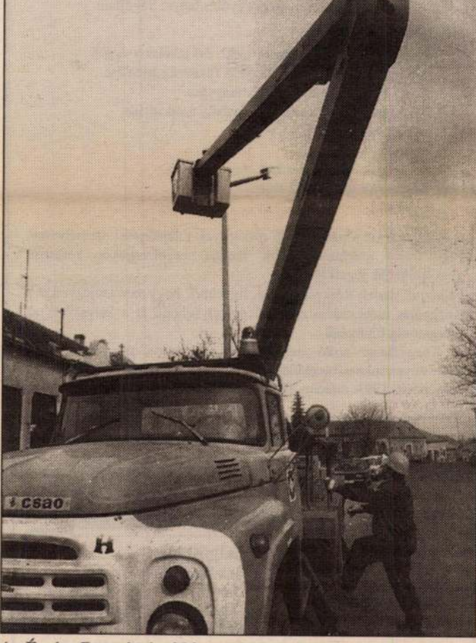
Az Émász Rt. szécsényi kirendeltségének dolgozója, a város és a közel tucatnyi, területükhöz tartozó községben folyamatosan ellenőrzik a közvilágítást, s ennek részeként cserélik a lámpatesteket. Felvételünk Szécsény belvárosában készült. Fotó: Gyurkó
