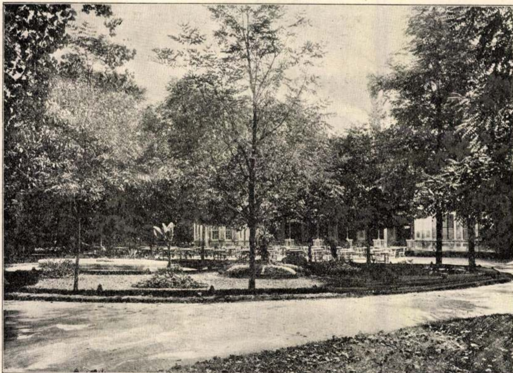
A GYÓGYTEREM ÉPÜLETE.
