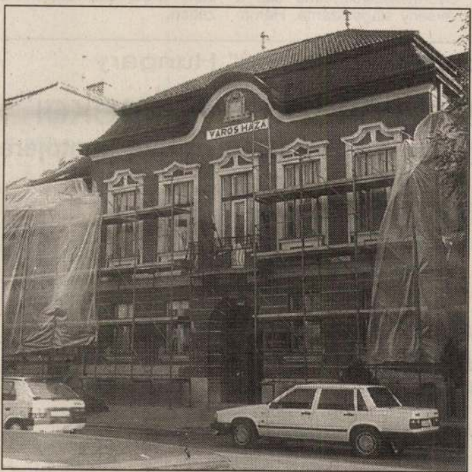
TATAROZZÁK A VÁROSHÁZÁT. Felújítják a városházát Marcaliban. A kétfélmillió forintba kerülő munkát Bedő Béla építési vállalkozó munkásai végzik: vakolnak, s újrafestik az ajtókat, ablakokat. Fotó: Kun G. Tibor
