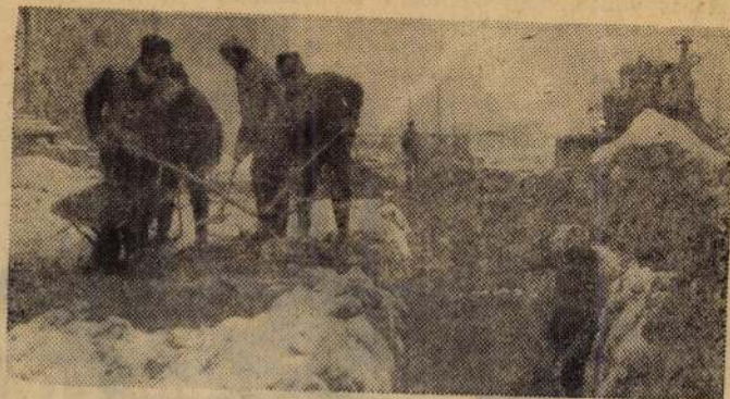
Folyik a csatornázás Tatabányán, a VI-os szomszédiasági egység új lakótelepén. Ennek legnagyobb részét ma már géppel végzik, csak a csótoldások és az aknák betonozásához kell még a hagyományos kubikos munka.
