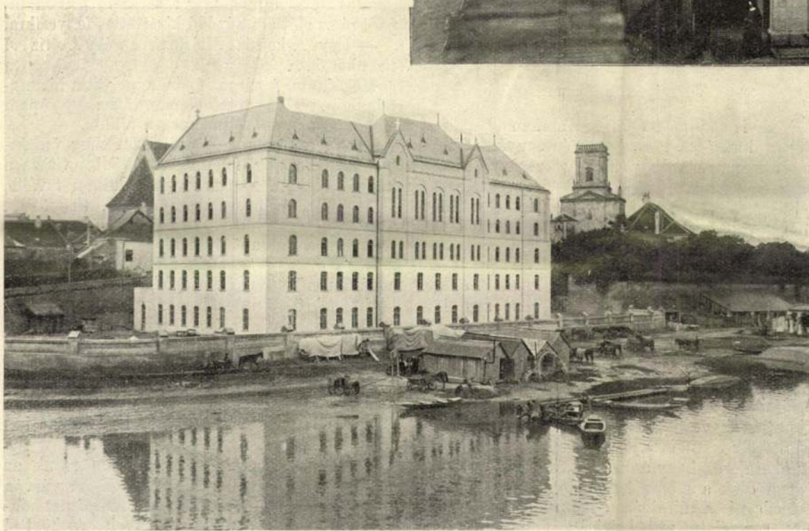
AZ ÉPÜLET A DUNA FELŐL NÉZVE.
